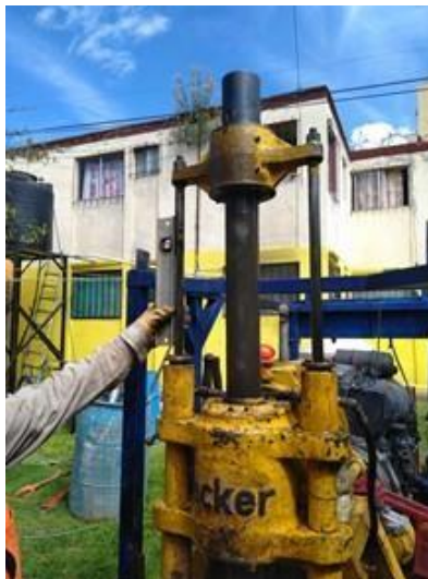
Foto 5. Instalación de la máquina de perforación
