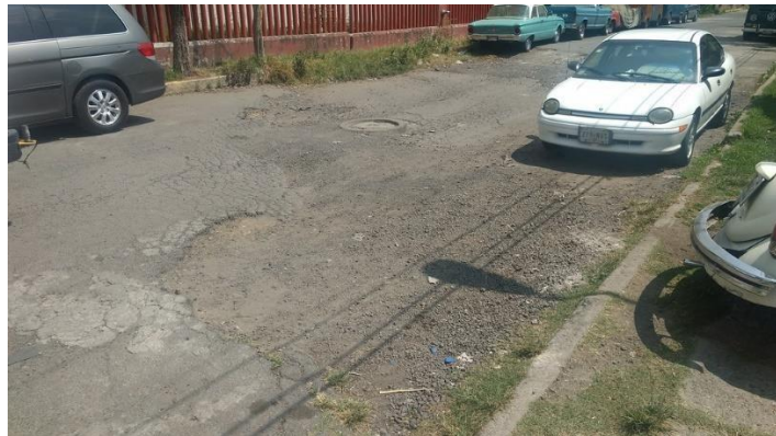
Fotos Nos. 2 y 3. Se muestran las deformaciones en el terreno a causa del proceso de agrietamiento en la zona donde se ubica la Villa Centroamericana.
