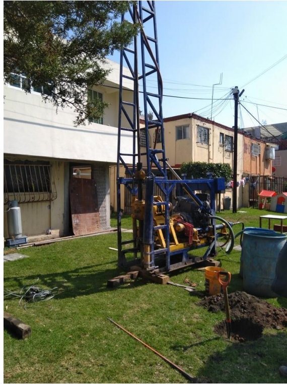
B.11. Se muestra el sitio donde se llevó a cabo la perforación del SM-2.
