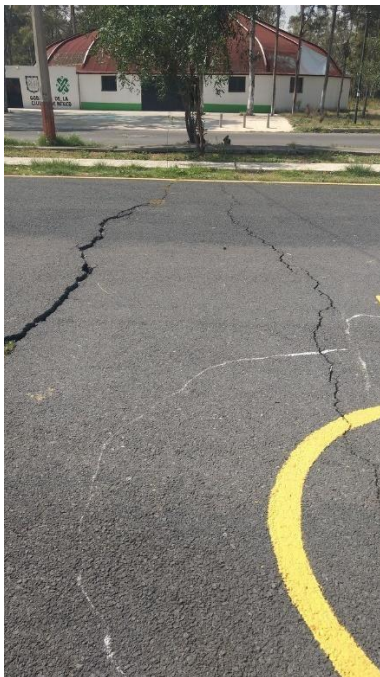
Fotos Nos. 2 y 3. Se muestran las deformaciones en el terreno a causa del proceso de agrietamiento en la zona donde se ubica la Villa Centroamericana.
