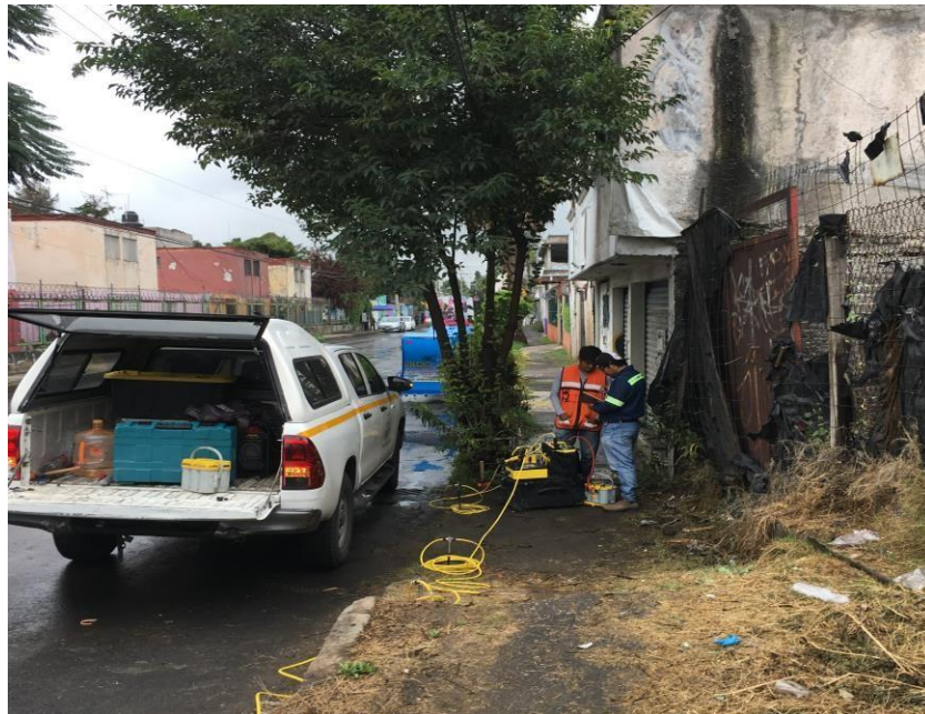
A.16. Trabajos efectuados para la Línea de D-D 4 sobre Calle Langosta.
