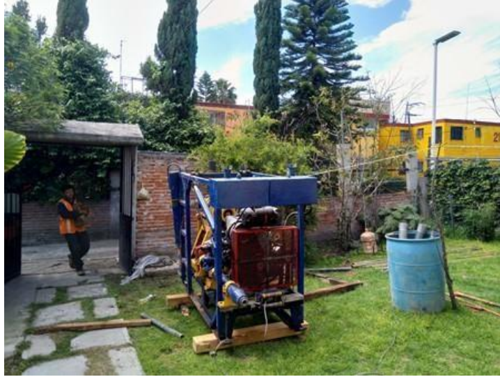
Foto No. 4. Equipo de perforación para los sondeos
