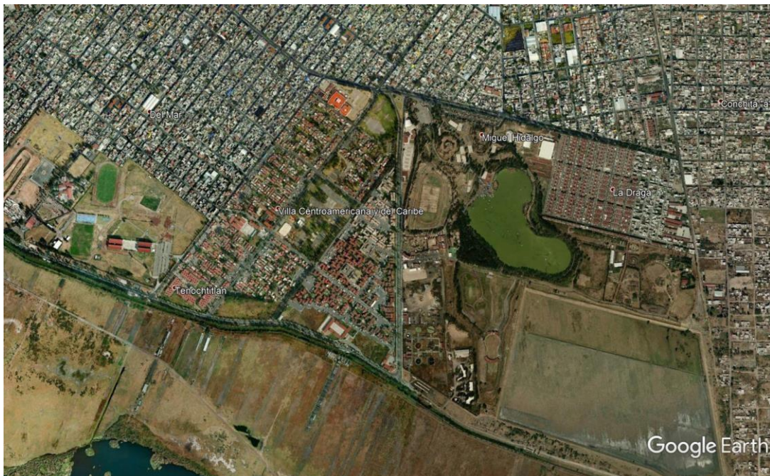
Figura No. 13. Para finales del año 2009, se concluyen los trabajos de construcción del Hospital Regional de Tláhuac.
