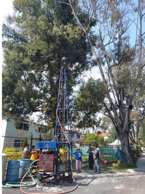
B.19. Ubicación del sitio donde se llevo a cabo la perforación del sondeo SM-3.
