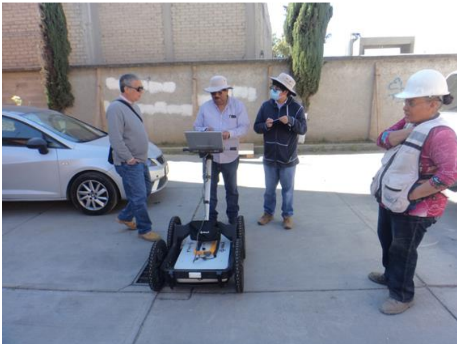
FOTOGRAFÍA 2 Exploración con GEORADAR (antena de 250 MHz), Línea 1 F2.
