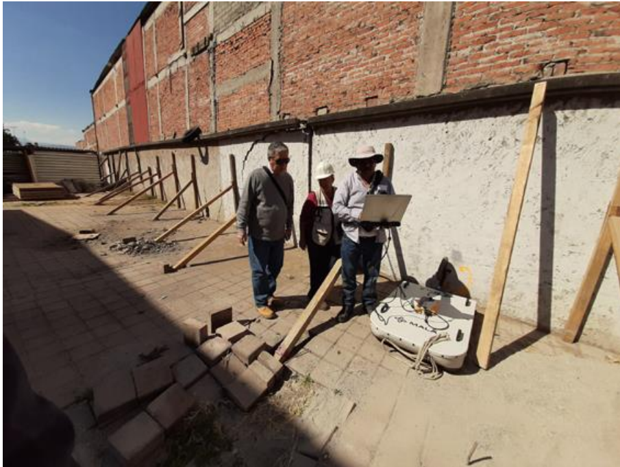
FOTOGRAFÍA 11 Exploración con GEORADAR (antena de 100 MHz), Línea 2 F1.
