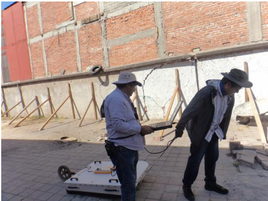
FOTOGRAFÍA 10 Exploración con GEORADAR (antena de 100 MHz), Línea 1 F2.
