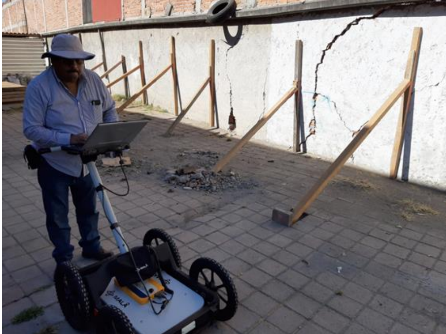
FOTOGRAFÍA 1 Exploración con GEORADAR (antena de 250 MHz), Línea 1 F1.
