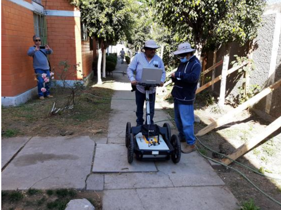
FOTOGRAFÍA 3 Exploración con GEORADAR (antena de 250 MHz), Línea 2 F1.
